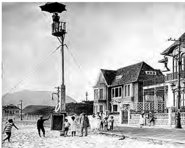
Figura 7: Posto de Salvamento 1910
